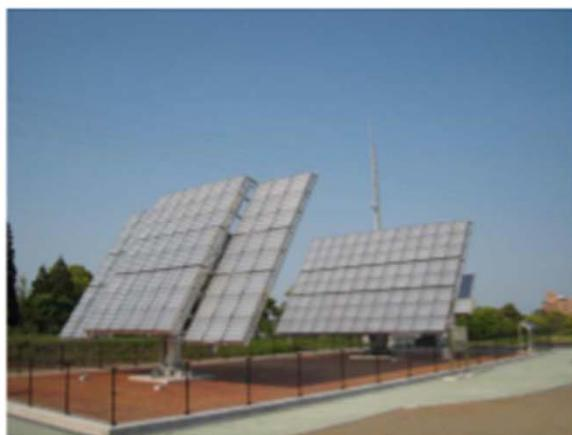
〇〇大学では〇〇〇〇〇株式会社との共同研究契約を結び、KB キャンパスにおいて14kW集光型太陽光発電システム2基を設置しました。発電パネルの大きさは縦7m、横10mであり、集光型のシステムとしては国内最大の出力(1基あたり)を有します。
