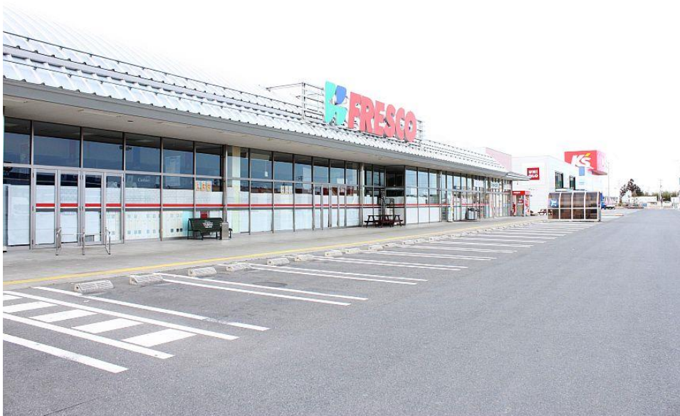
▲従業員の避難により休業したスーパーマーケット
