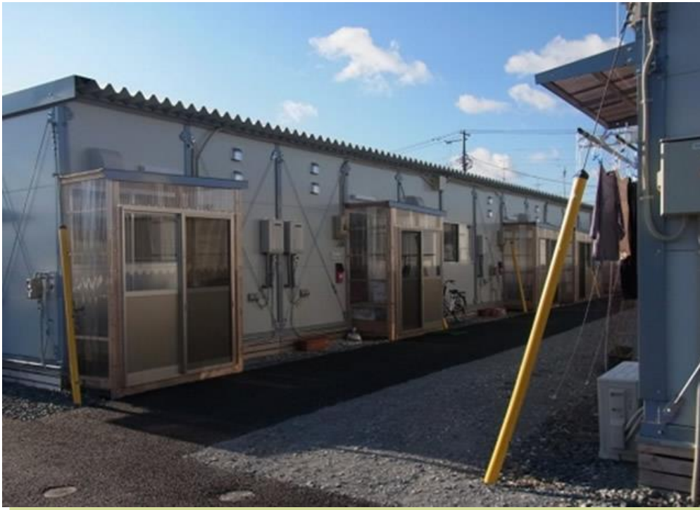
▲南相馬市内に建設された仮設住宅
