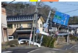
内灘町西荒屋地内 (液状化)
