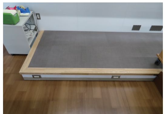
教卓の側面にもコンセント
